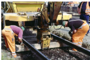
Einbringen der Neuschwellen
