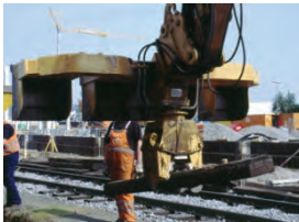
Entfernen der Altschwellen
